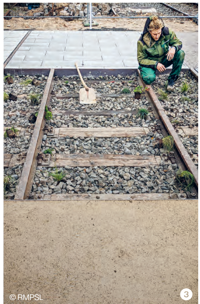
1. Stresstest durch Abfallwirtschaftsbetriebe Köln 2. Begehung Testfläche durch Fachämter 3. Bepflanzung Musterfläche
